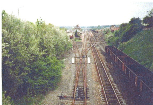
Vue sur la gare de Bastogne-Sud depuis le pont du contournement routier.
