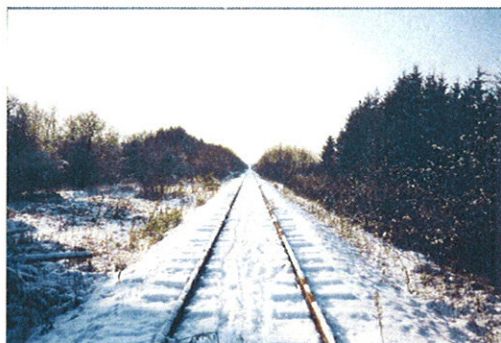
Aux environs de l'ancien point d'arrêt de Villeroux (L163) en décembre 2002.
