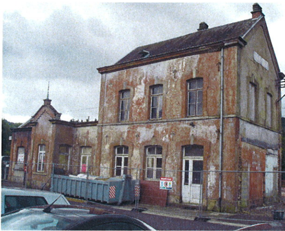
Vue de la façade avant, depuis le parking des voyageurs
