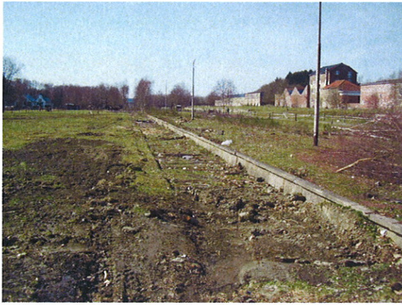
Bastogne-Sud (22/03/2011) emplacement de l'ancienne voie 2.
